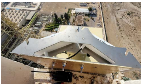
CENTRALE THERMIQUE, ÉGYPTTE
