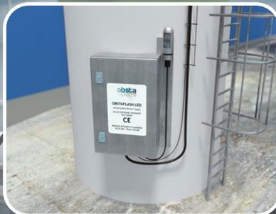
Cellule photoélectrique orienté au nord
