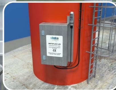
Cellule photoélectrique orienté au nord
